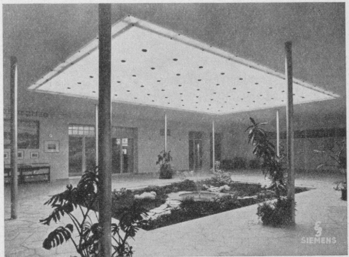
Leuchtstoffröhren-Decke in einem Foyer
