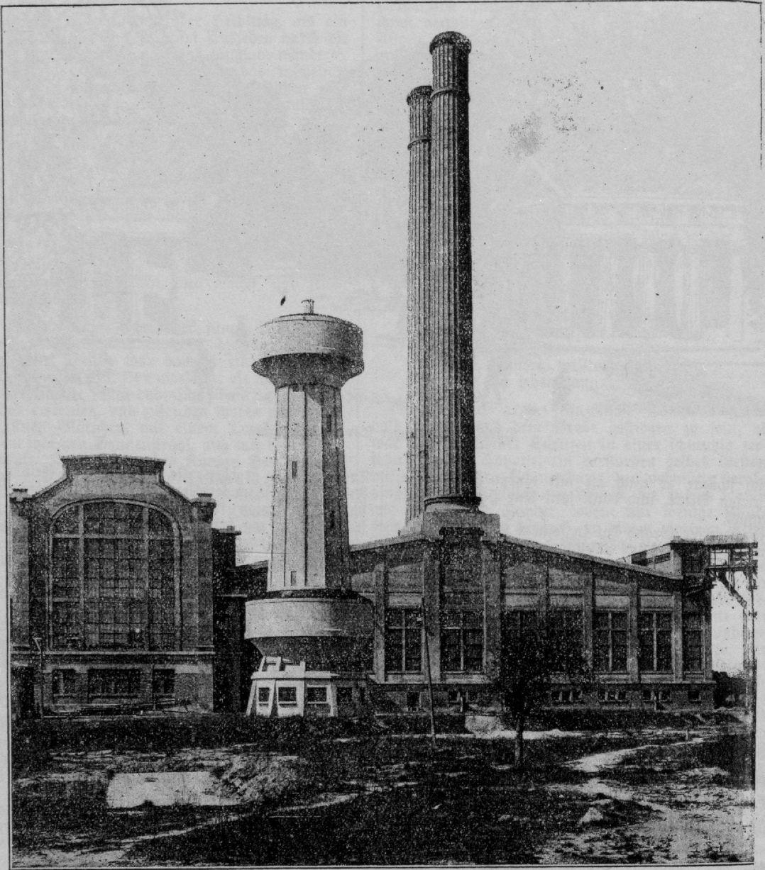
Das neue Kraftwerk der Saargruben in Fenne.
