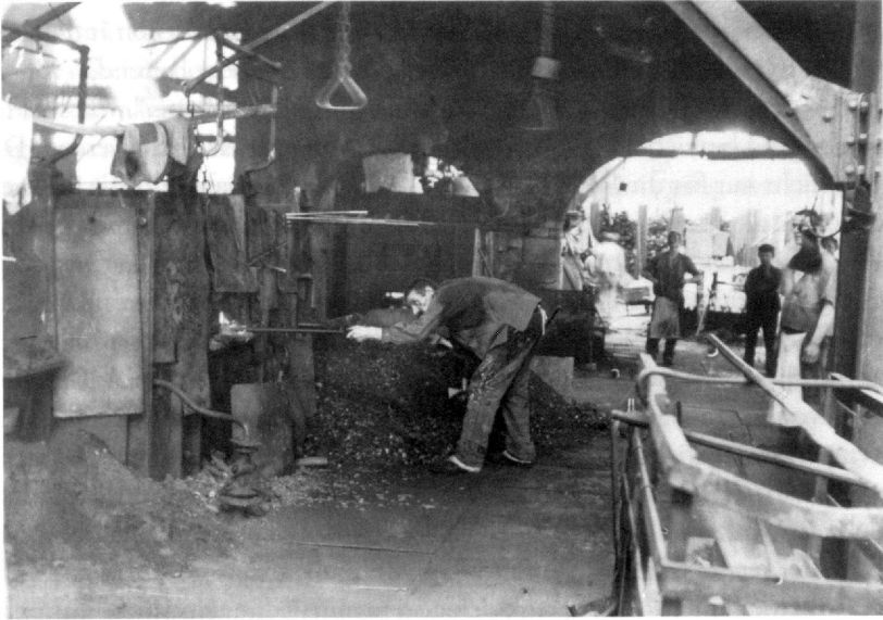
Abbildung 13: Puddler im Neunkircher Eisenwerk (1914). 72
