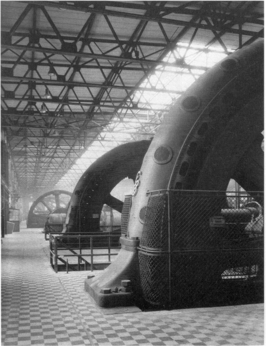
Abb. 5: Gebläsemaschinenhaus. Im Vordergrund zwei Gasgebläsemaschinen des Baujahrs 1914.
