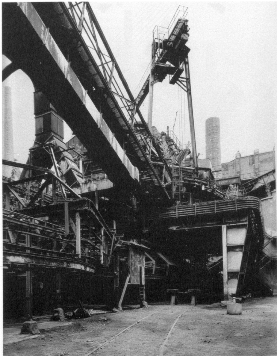
Abb. 3: Sinteranlage von 1928. Hier wurde das Erz für den Hochofenprozess optimiert.
