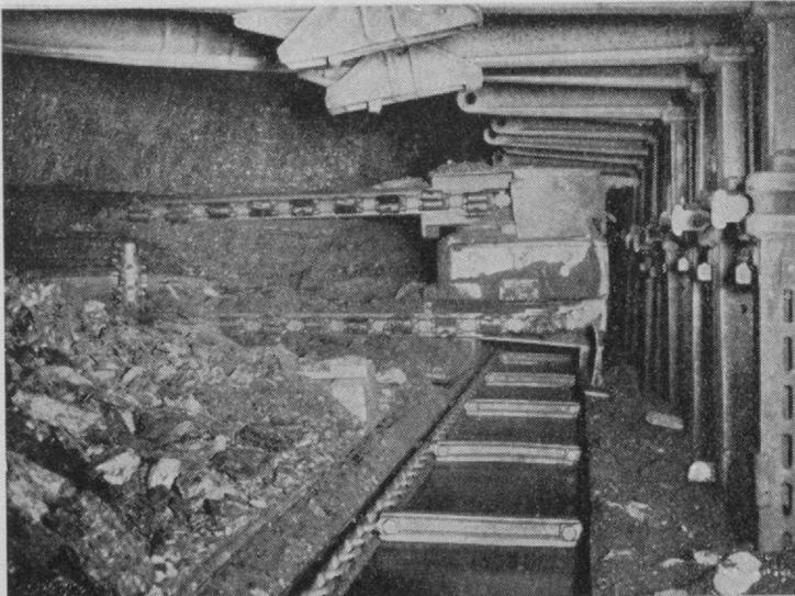
Bild 1: Schrämmaschine auf dem Panzerförderer mit Doppelschram und Pilz
