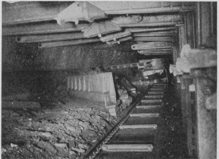
*Bild 4: Schrämmaschine mit nachfolgendem Räumflug*
