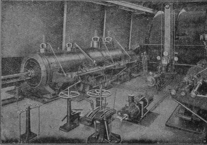
Machines d'extraction à vapeur à deux cylindres 1600 coups de piston.
