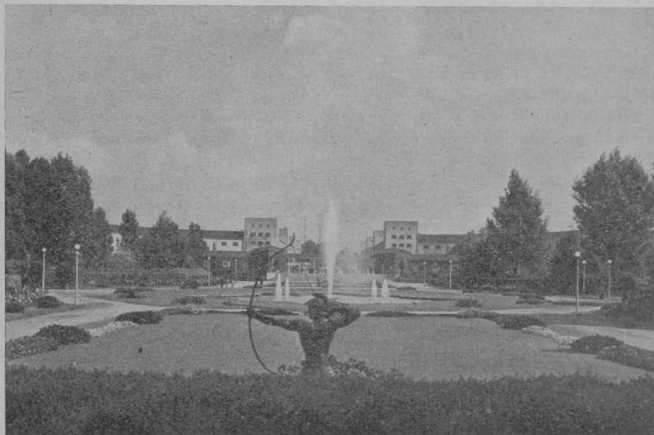
Im Hindenburgpark, Blick von der Terrasse
