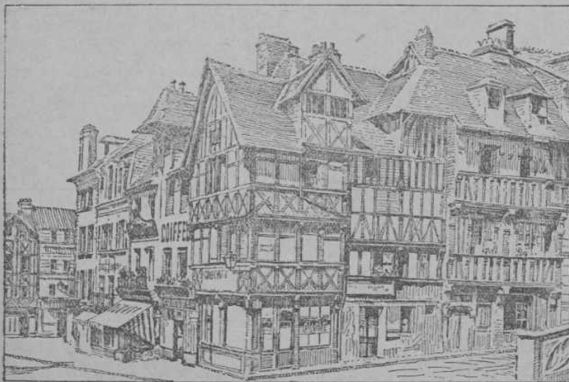
Fachwerkhäuser in Lisieux.
