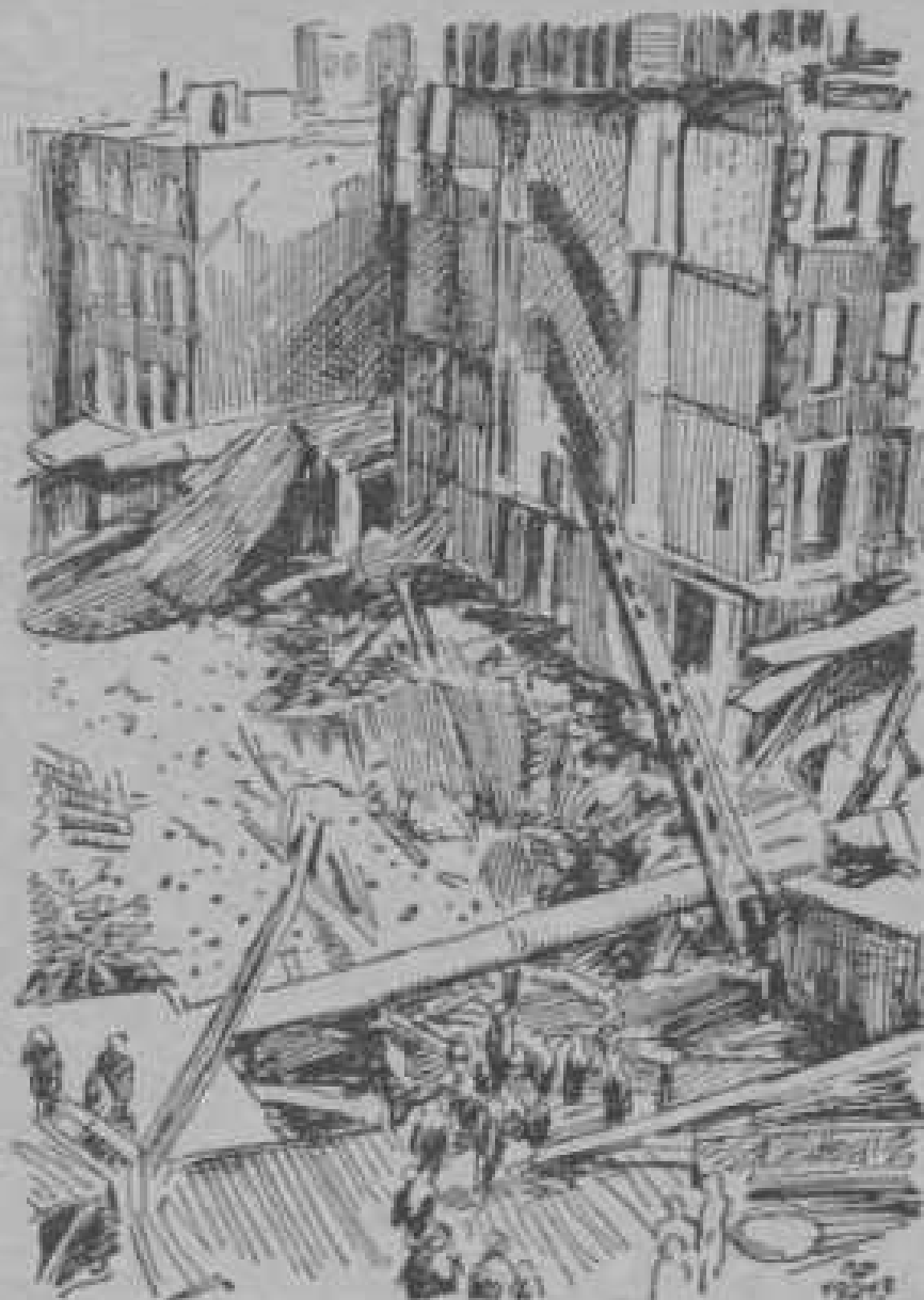
Häusereinsturz in New York
