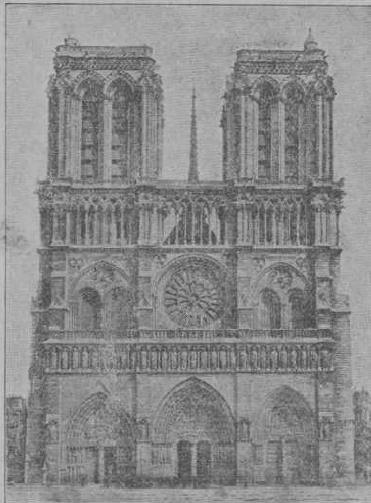
Die Notre Dame-Kirche in Paris baufällig. Die berühmte Notre Dame-Kirche in Paris, eine der ältesten großen Kirchen der Welt überhaupt, da sie schon im Jahre 1170 erbaut wurde, ist baufällig geworden. Das Mauerwerk zeigt bedenkliche Schädigungen durch Witterungseinflüsse und die Wiederherstellung wird viele Millionen Frank kosten.
