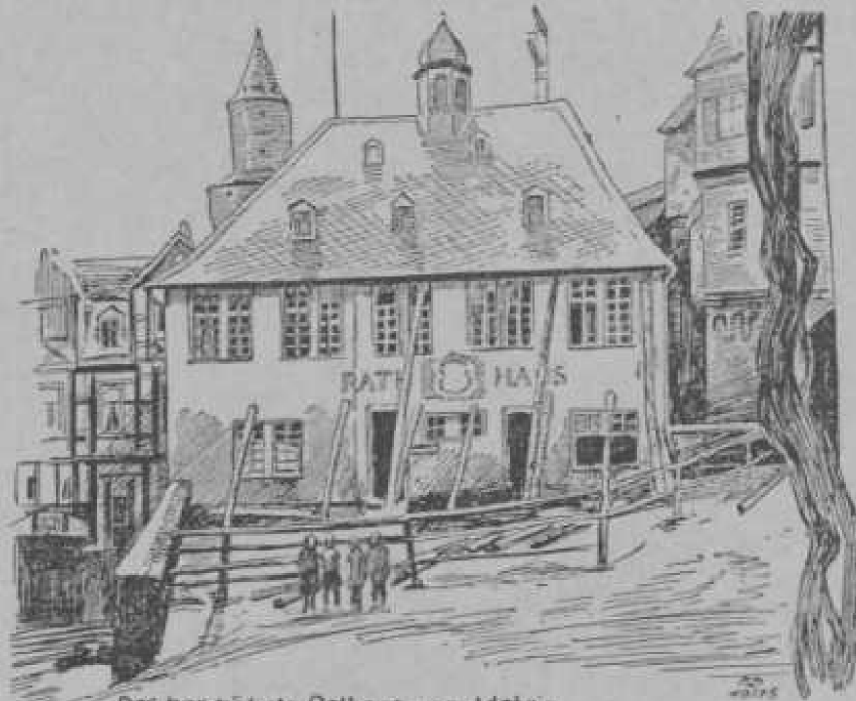
Das beschädigte Rathaus von Idstein
