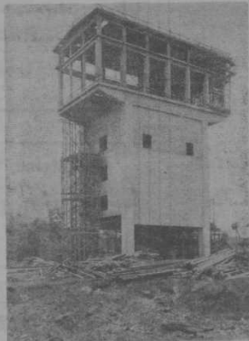
Förderschachturm St. Barbara Baubausführung: Saar-Bauindustrie A.-G. Saarlouis
