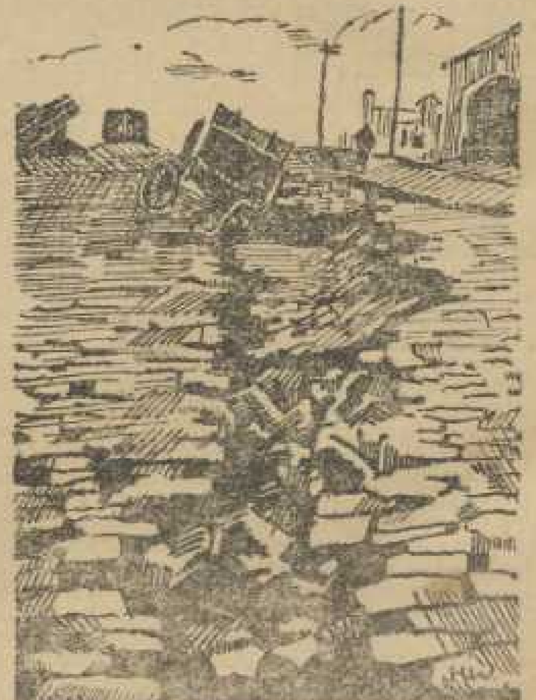
Erdbebenspalte in einer Straße von San Francisco
